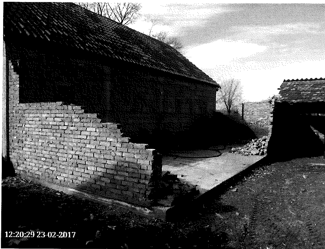
Slika 25. Objekat br.25- Mala garaža
