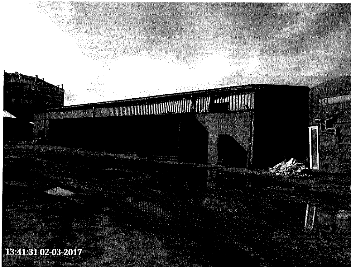
Slika 34. Objekat br.34- Garaže (Mehanizacija)
